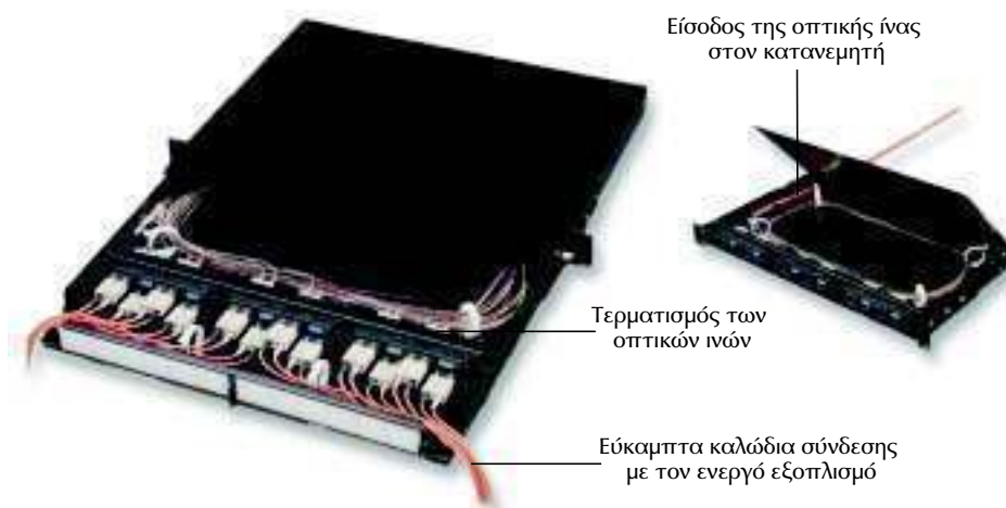
Εικόνα 5-10 Ο οπτικός κατανεμητής. Στο μπροστινό τμήμα του κατανεμητή καταλήγουν οι ίνες, που έχουν εισαχθεί σ'αυτόν. Στην εικόνα φαίνονται τα εύκαμπτα οπτικά καλώδια, τα οποία συνδέονται στις υποδοχές, στην μπροστινή πλευρά του κατανεμητή
